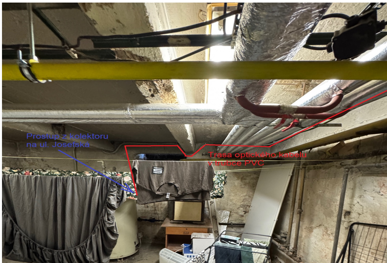
Trasa optického kabelu ze sekundárního kolektoru povede stávajícími instalačními trasami – prostor 016
