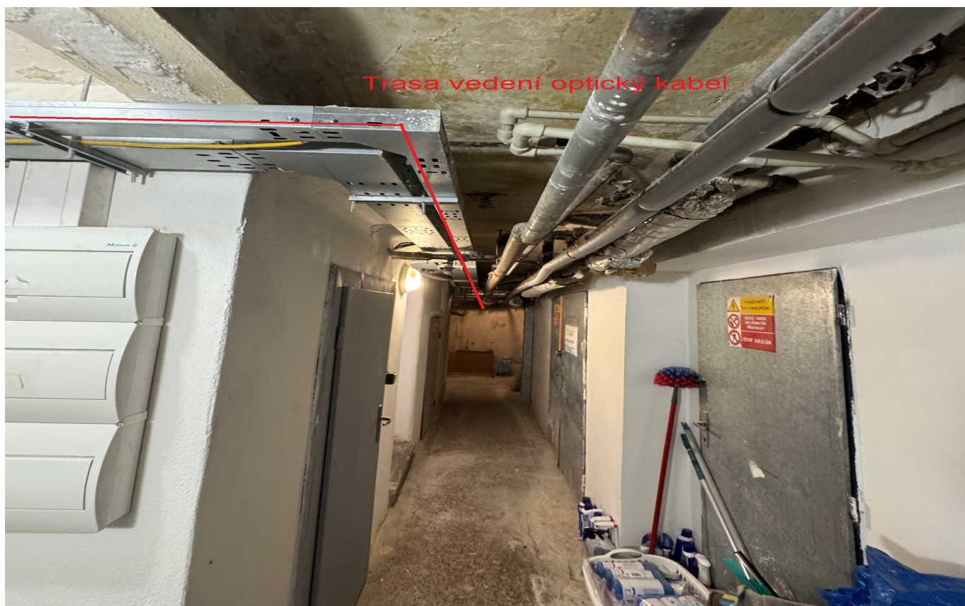
Trasa optického kabelu na chodbě ve stávajícím žlabu – chodba 002
